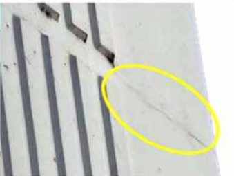
컨스트럭션 조인트 시공이음새누수 상단부이음새크랙10-20mm
