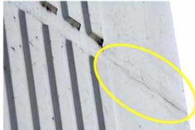
컨스트럭션 조인트 시공이음새누수 상단부이음새크랙10-20mm
