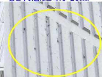
컨스트럭션 조인트 시공이음새누수 상단부이음새크랙10-20mm
