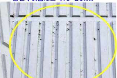
컨스트럭션 조인트 시공이음새누수 상단부이음새크랙10-20mm
